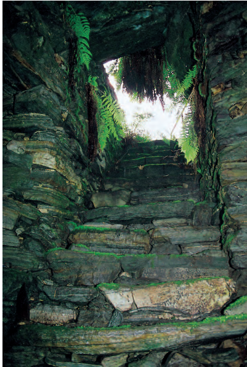
493. La cantina oggetto di studio a Moghegno.
