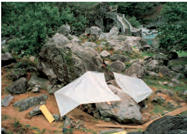
458. La zona dello scavo durante i lavori.
