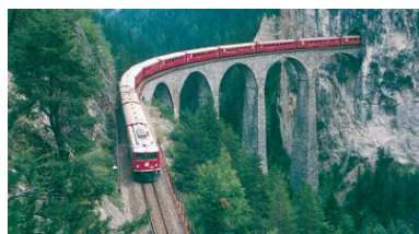
Il viadotto di Landwasser
